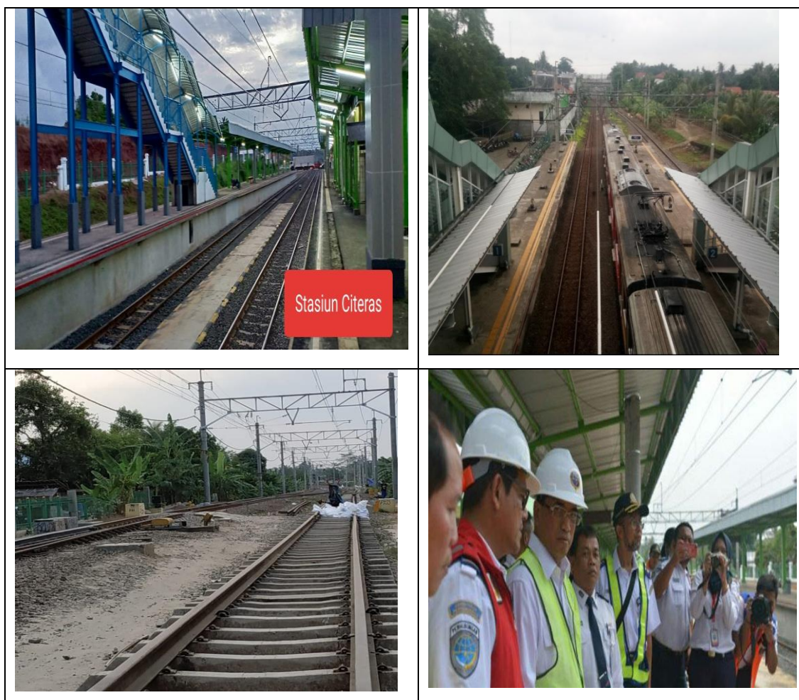
Gambar 1.7 Pembangunan Double-double Track Maja-Rangkasbitung.
