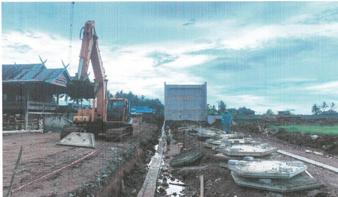
Pekerjaan Overpass Manggalung, untuk Sisi Gunung mulai Pemasangan Dinding Nehemiah dan untuk Sisi Laut Clearing tanah dasar
