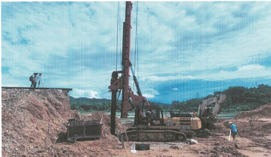
Pekerjaan pengeboran borepile dimulai dari abt 1 sudah mencapai kedalaman 21 meter dari total kedalaman 26 meter
