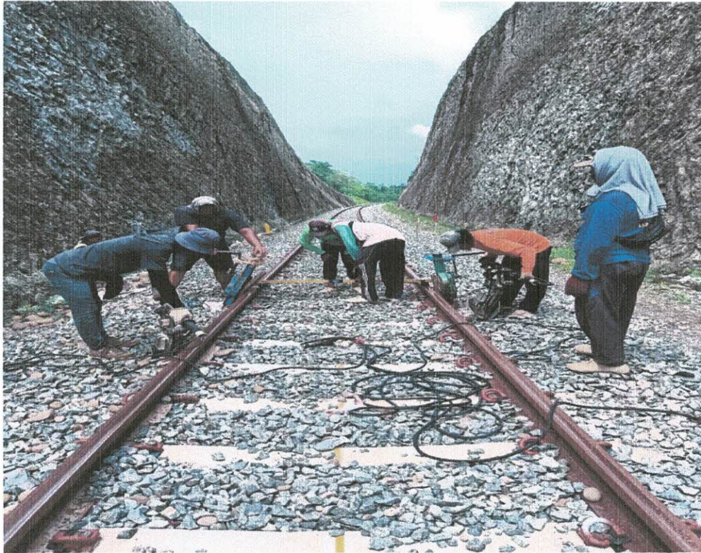
Kegiatan listringan dan HTT pada km 73+700 (ct416) dengan jumlah pekerja 8 orang
